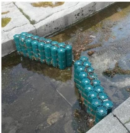
**Photo 18 : Omniflots® servant de pré-barrage pour créer le bassin de réception.**
