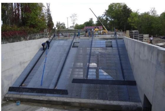
**Photo 1 : plan de grille fine incliné à  $26^\circ$  et exutoires de Las Rives (hors d'eau).**
