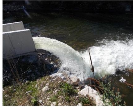
**Photo 4 : chute à l'extrémité aval de la goulotte de transfert jusque dans l'Ariège.**
