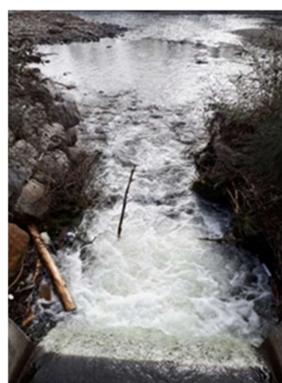
**Photo 12 : seuil de contrôle du débit et restitution directe dans le tronçon court-circuité de l'Ariège.**
