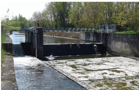
**Photo 24 : vue depuis l'aval du canal de décharge de Pébernat avec l'ouverture de l'exutoire de dévalaison à  $2 \text{ m}^3$  (à gauche) et la vanne toit fermée (à droite) – 18/04/17**
