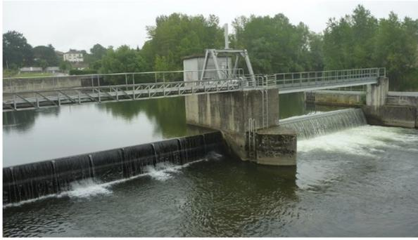
**Photo 13 : clapets de régulation du barrage.**
