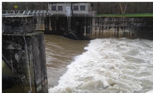
**Photo 25 : vue depuis l'aval de la vanne toit ouverte lors d'un coup d'eau en 2018**
