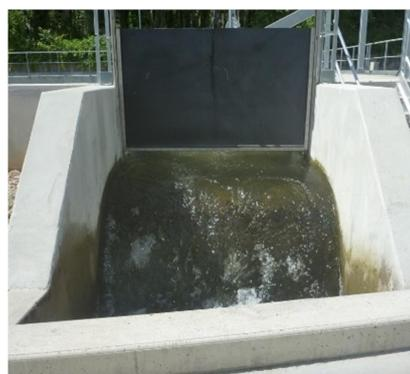
**Photo 2 : seuil de contrôle du débit à l'extrémité aval de la goulotte collectant les exutoires.**
