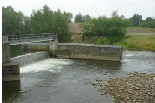
**Photo 14 : vue du débit réservé restitué par le clapet au barrage et la passe à poissons.**
