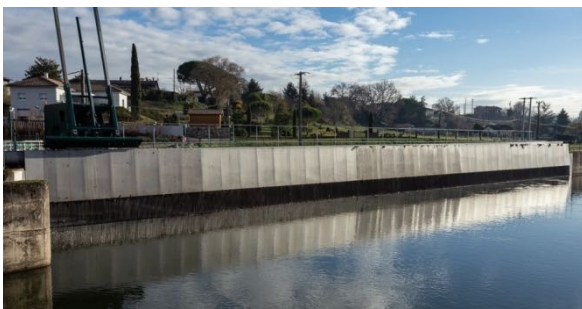
Photo 11. Vue aval du plan de grille orienté de la prise d'eau de Pébernat
