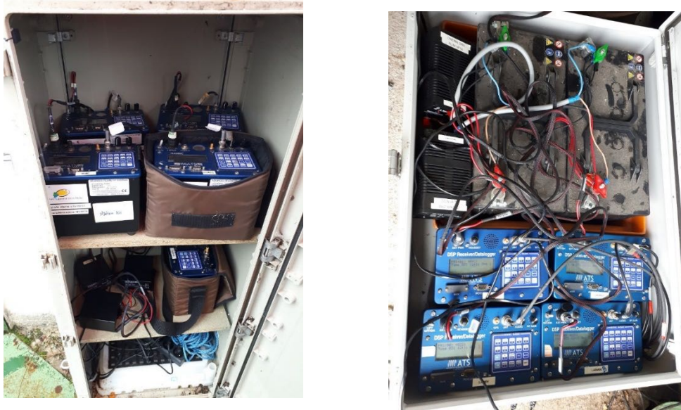
Photo 14. Exemples d'installations de récepteur-enregistreurs utilisés pour la détection des anguilles sur l'Ariège
