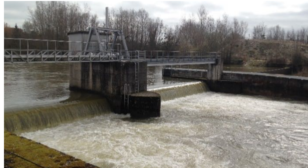
Photo 10. Clapets de régulation du barrage de Pébernat en situation de fort déversement
