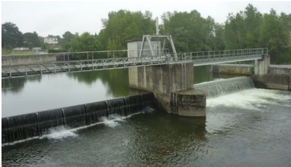
Photo 9. Clapets de régulation du barrage de Pébernat en situation de restitution du débit réservé
