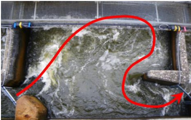
Figure 3 : Détermination visuelle du type d'écoulement se produisant dans les bassins de la passe de Vichy.
