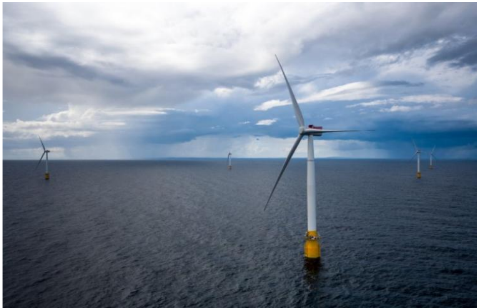
Figure 3 : premier parc éolien flottant Hywind en Ecosse (Source : Øyvind Gravås Woldcam - Statoil ASA).
