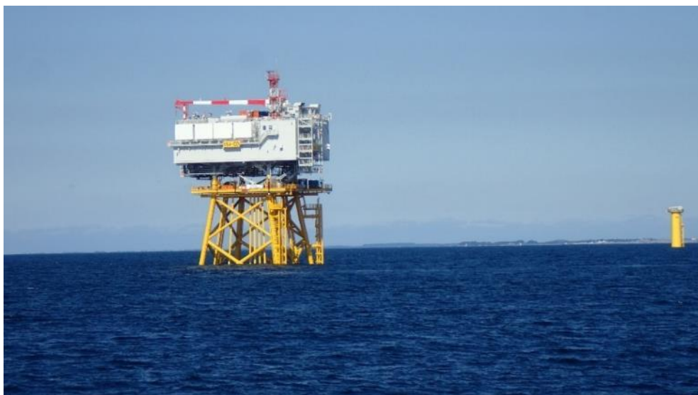
Figure 29 : poste de raccordement du parc d'éoliennes en mer « Banc de Guérande » au large de Saint-Nazaire (photo : S. Michel / Office français de la biodiversité).
