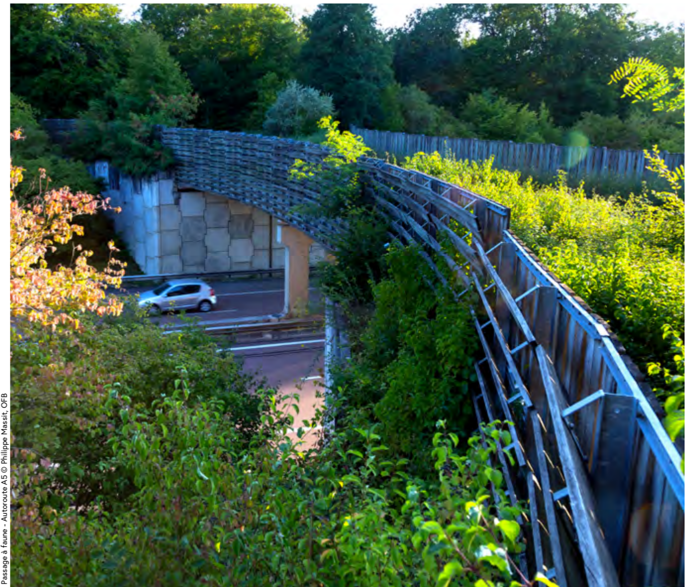
Passage à faune - Autoroute A5 © Philippe Massit, OFB
